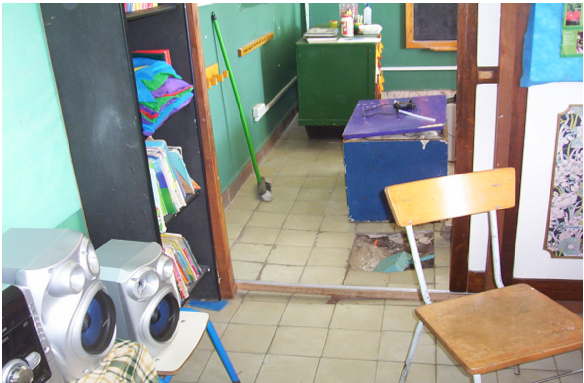
Fig 23 _ contrapisos hundidos
