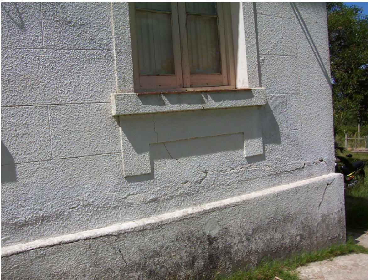
Fig 33_ Fisuras en pared exterior
